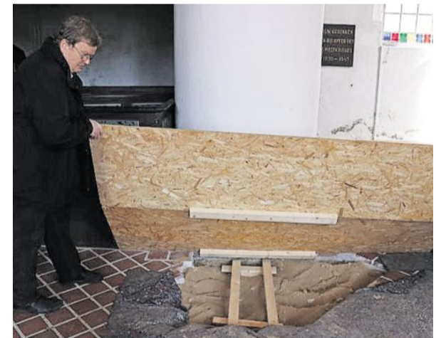
Pastor Thorsten Niehus zeigt eine „Probebohrung“, die die Bauexperten im Altarraum gemacht haben, um den Untergrund zu inspizieren.
